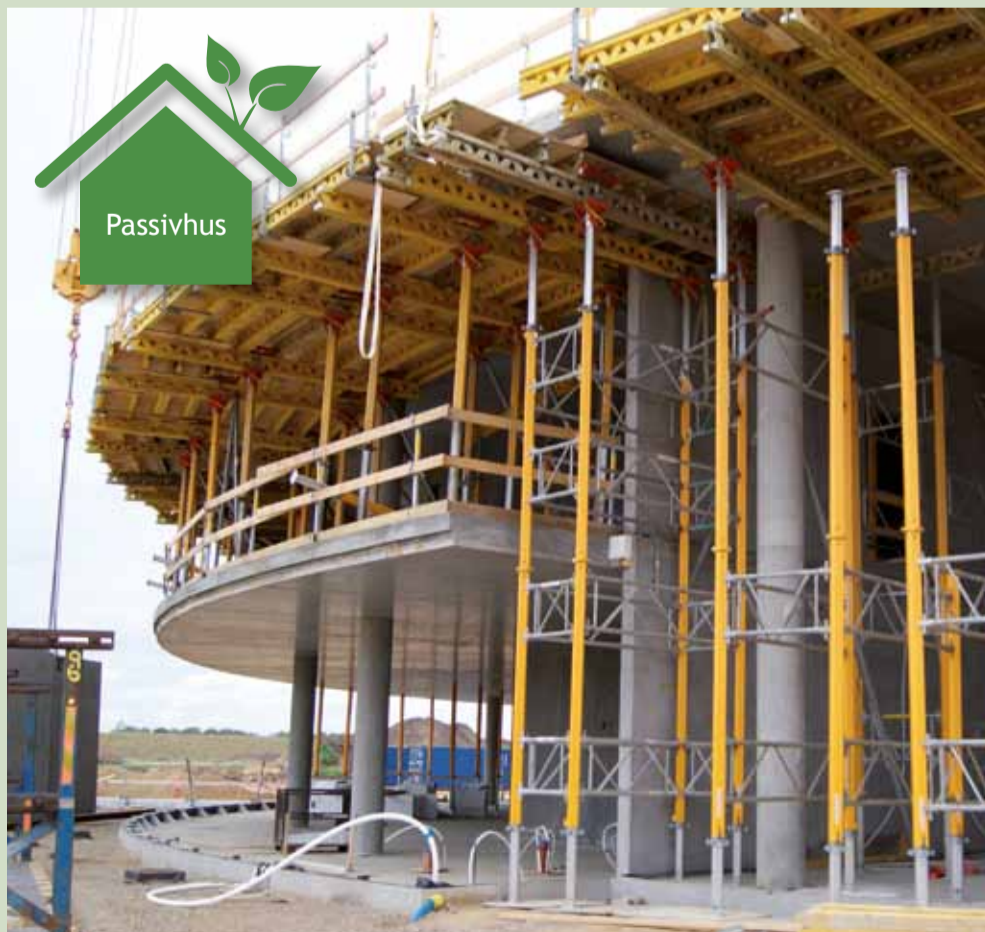
De første 2 etager er monteret på SEs nye domicil i Esbjerg.
